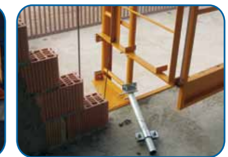
Arriostramiento a planta Tie and anchoring
